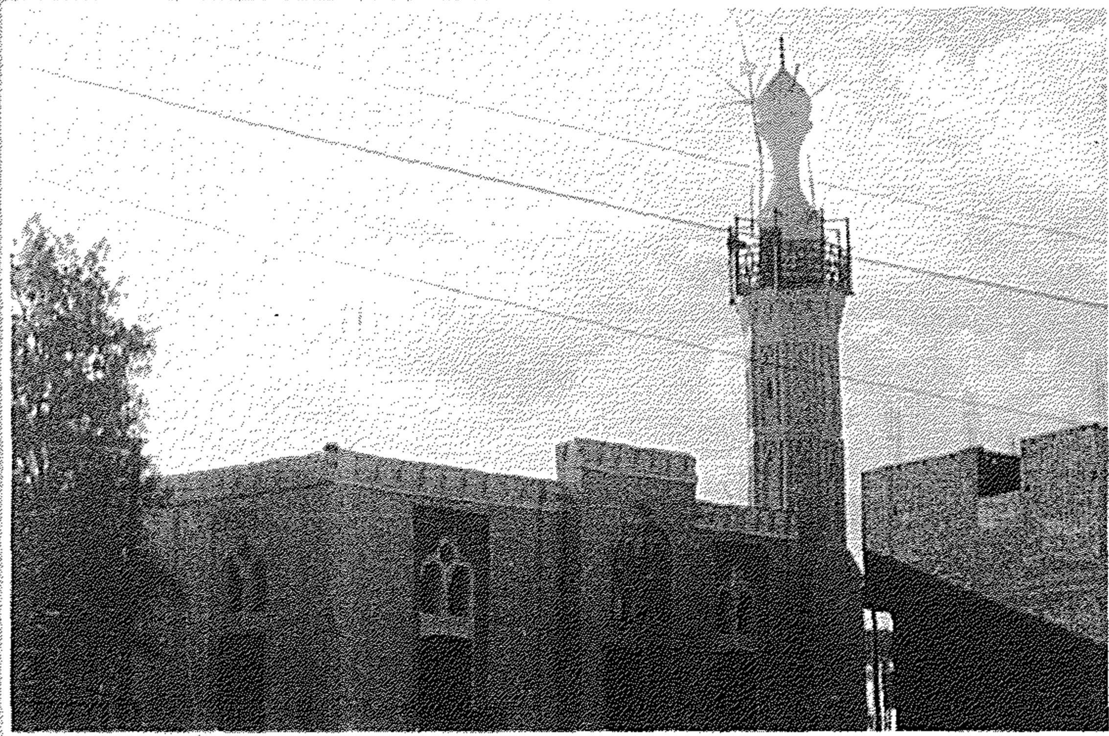
لوحة رقم ( ١٨٩ ) : الواجهة الشمالية الشرقية لمسجد الوكيل بسمخراط وتظهر بها المئذنة وقاعدتها وكذلك الشبابيك والنوافذ
